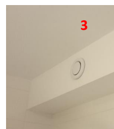
Exemple de soffite
