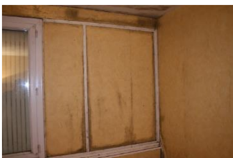
Photos prises lors de l'audit Traces noires de moisissures qui se développent sur les zones où il y a condensation
